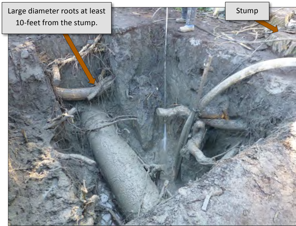
Figure 17. Dig site RWVC-51-13 (RWVIM-104-13)
