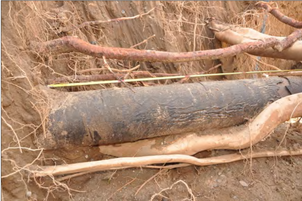
Figure 21. Dig site RWVIM-106-13.
